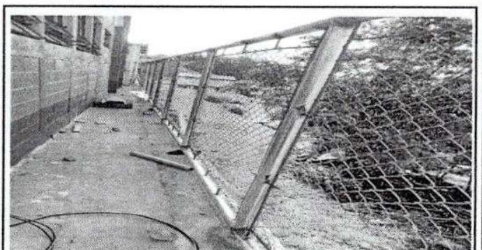
Foto 6: Reparación de tubo hg y malla galvanizada.
