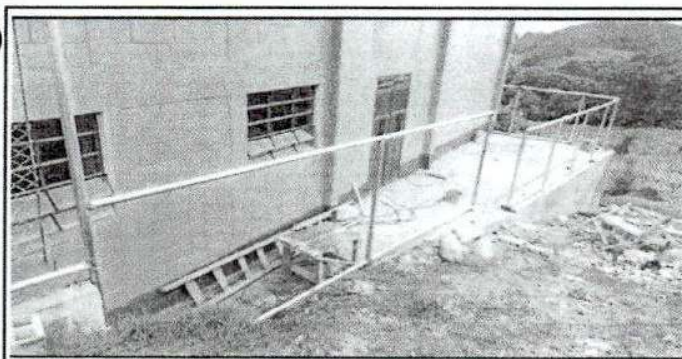
Foto 5: Reparación de tubo hg y malla galvanizada.
