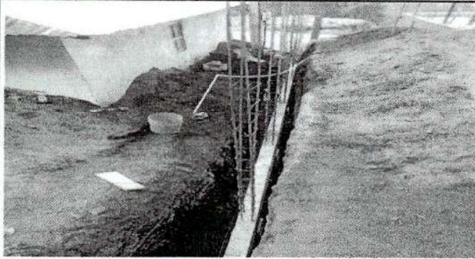
Foto 1: Reparación de muro perimetral de block con tubo hg y malla galvanizada, (soleras intermedias, cimiento de corrido, soleras de humedad, hiladas de block, tubos y columnas)
